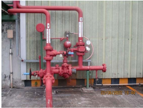
รูปที่ 42 Wet Alarm System
