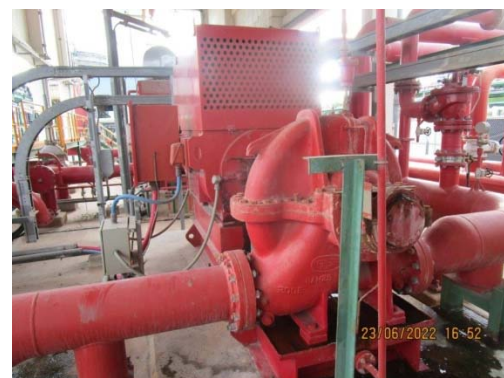
รูปที่ 58 Electric Fire Pump
