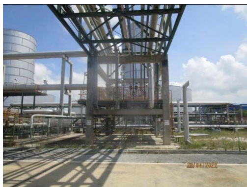
รูปที่ 5 ระบบรวบรวมสารอินทรีย์ระเหยเพื่อนำไปเผาไหม้ในเตาเผาของโรงงานอีเทนแครกเกอร์
