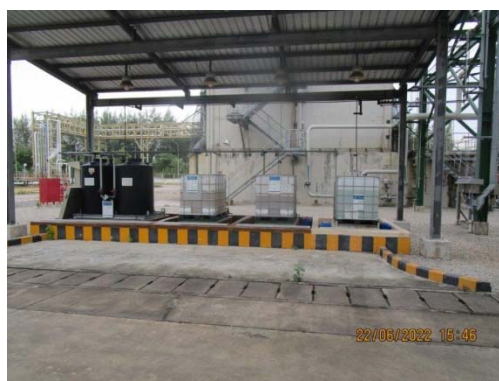
รูปที่ 41 ภาชนะจัดเก็บสารเคมีที่ปิดมิดชิดและทนการกัดกร่อน
