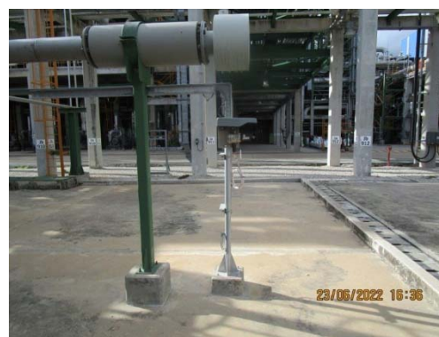
รูปที่ 36 Gas Detector บริเวณหน่วย RTO
