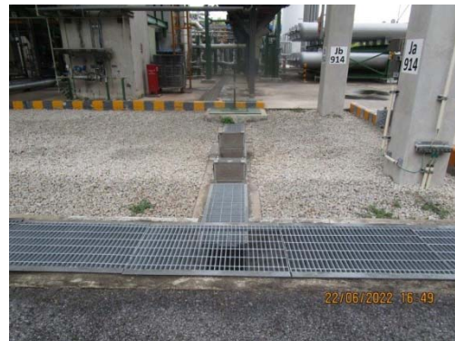
รูปที่ 8 จุดบำบัดด้วยตะแกรงละเอียด ก่อนระบายไปยัง Oil Separator
