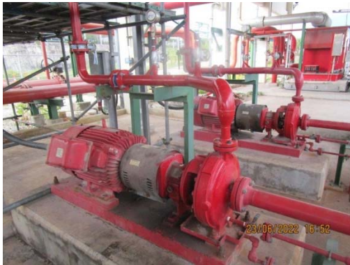
รูปที่ 59 Electric Jockey Pump
