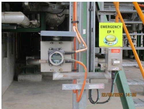
รูปที่ 49 Gas Detector
