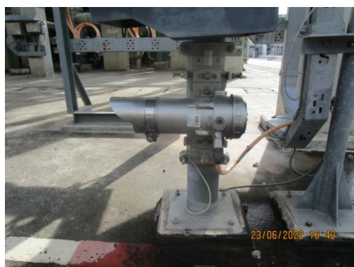
รูปที่ 51 Flame Detector
