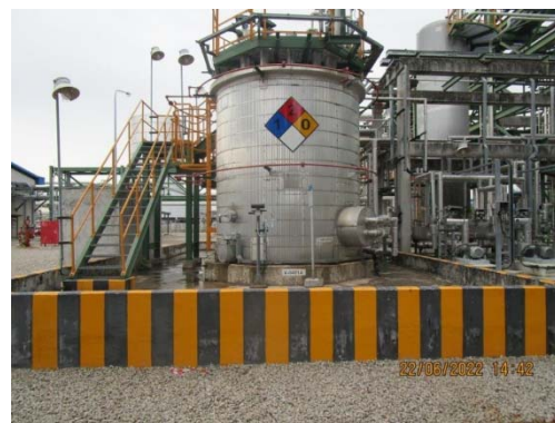
รูปที่ 34 คั่นคอนกรีตรอบถังกักเก็บ
