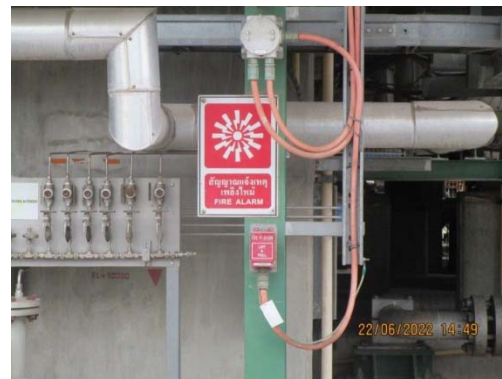
รูปที่ 50 Manual Pull Station
