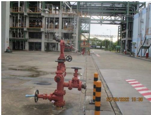
รูปที่ 44 Water Hydrants with Water / Foam Monitors
