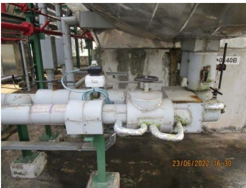
รูปที่ 61 Shut off Valve
