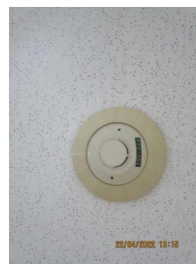
รูปที่ 52 Smoke/ Heat Detector
