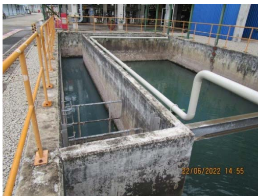
รูปที่ 9 Oil Separator
